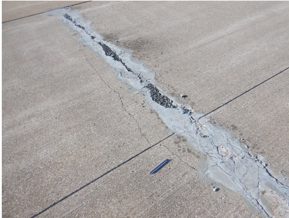
A01BR-02. ASR (Sample Unit No. 02).
