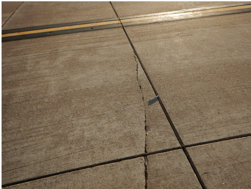
T03CN-04. Corner Break (Sample Unit No. 05).
