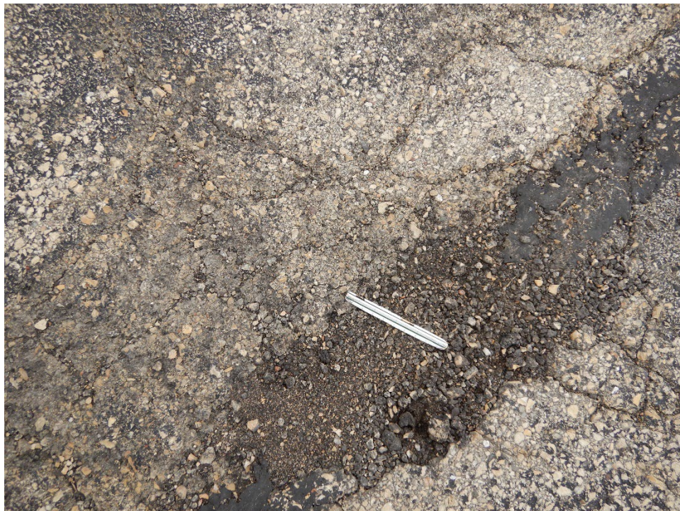
TH01CN-03. Raveling (Sample Unit No. 02).
