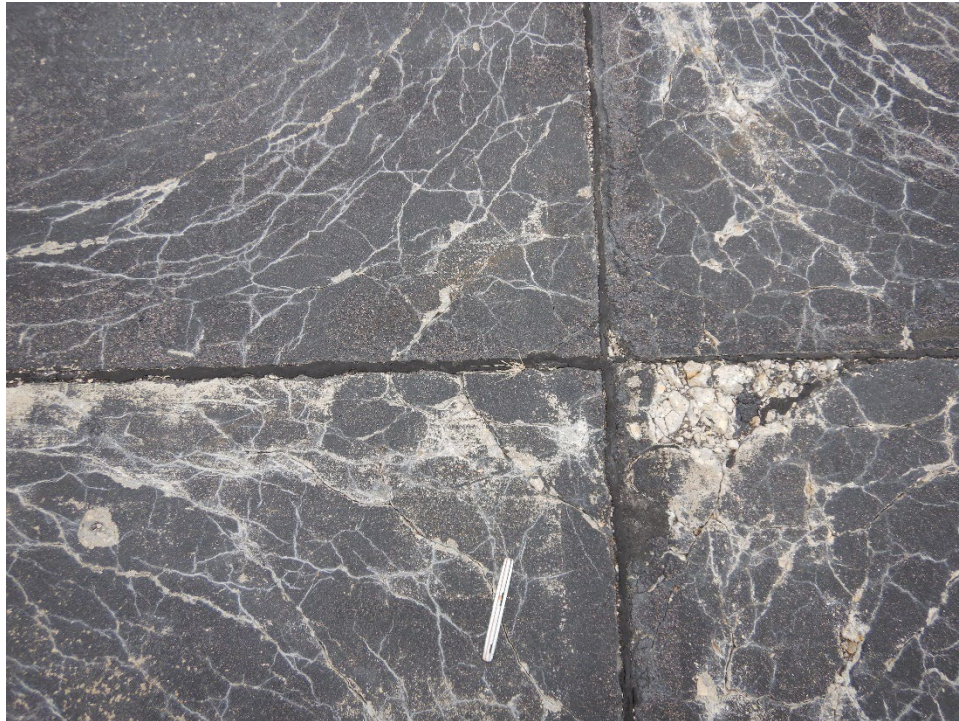
A02CN-03. ASR (Sample Unit No. 05).
