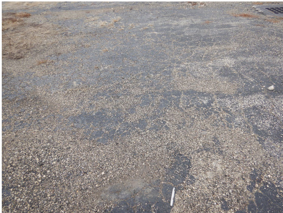
A01CN-03. Raveling (Sample Unit No. 03).
