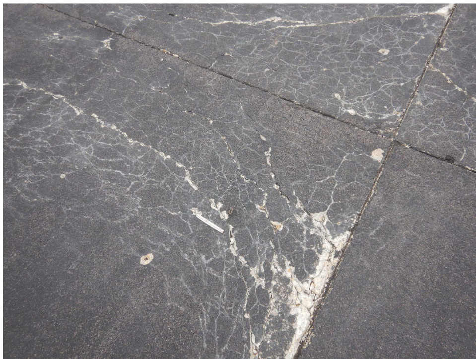
A02CN-01. ASR (Sample Unit No. 05).
