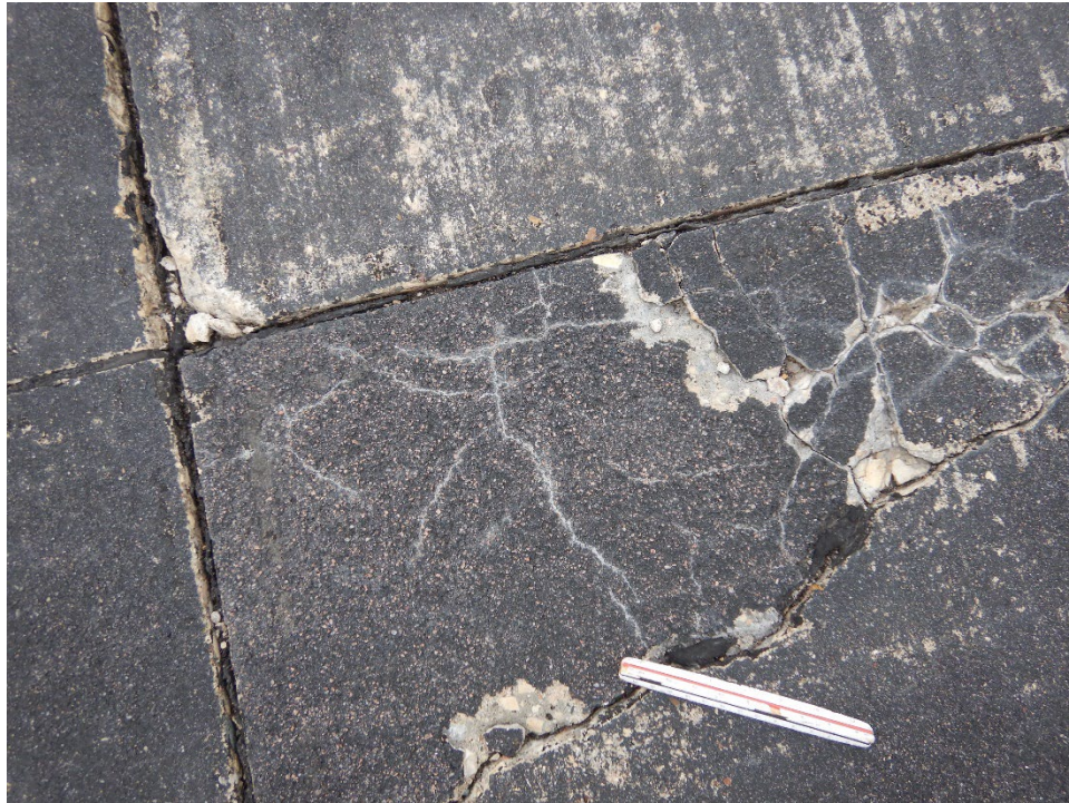
A02CN-01. ASR (Sample Unit No. 06).
