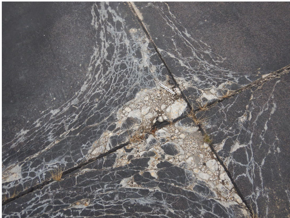
A02CN-03. ASR (Sample Unit No. 04).
