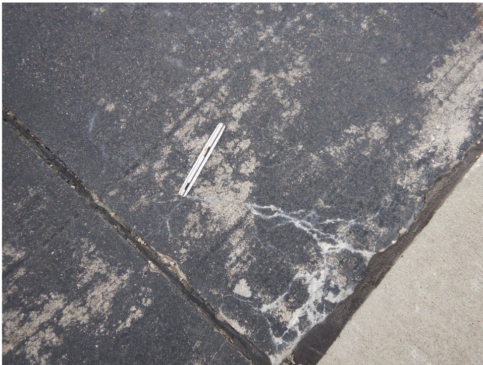
A01CN-01. ASR (Sample Unit No. 06).
