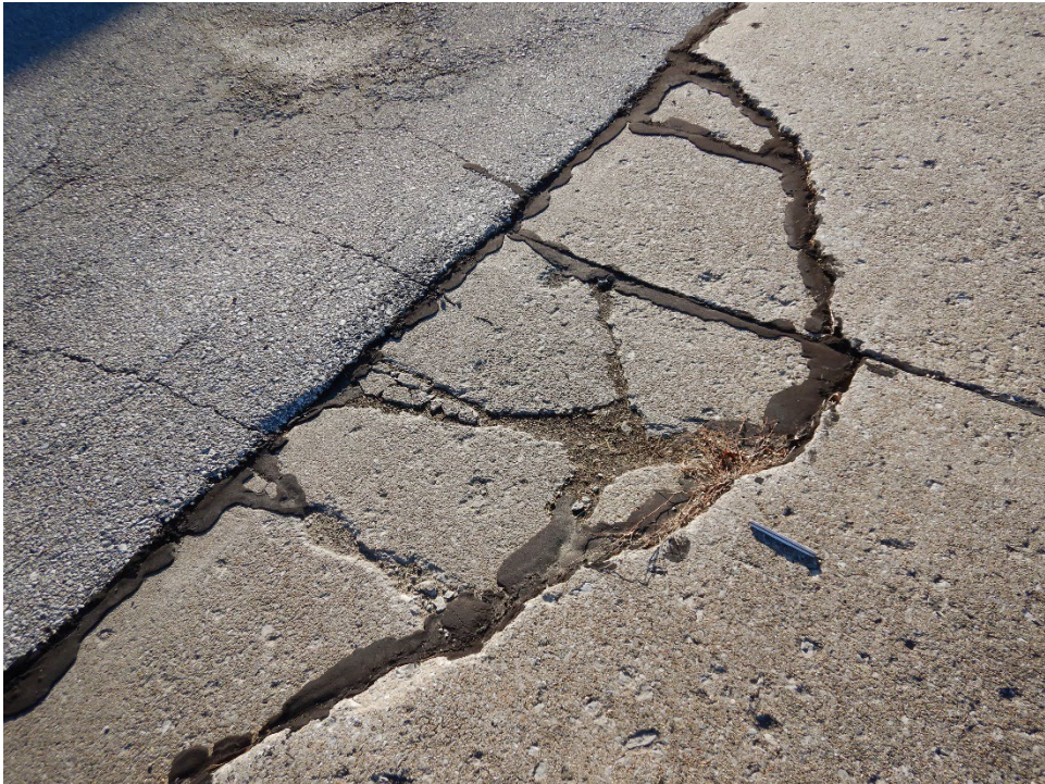
TH01IC-03. Corner Break (Sample Unit No. 02).
