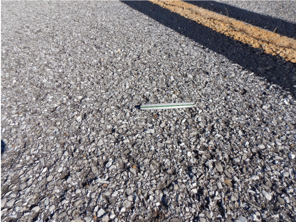
TEKE-01. Raveling (Sample Unit No. 04).
