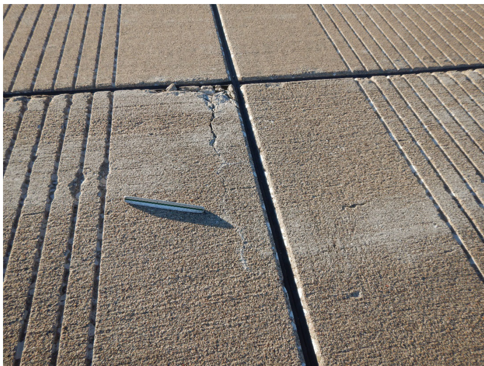
R08KE-01. ASR (Sample Unit No. 063).
