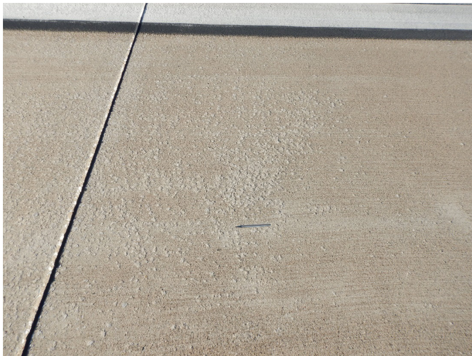
R14KE-04. Scaling (Sample Unit No. 01).
