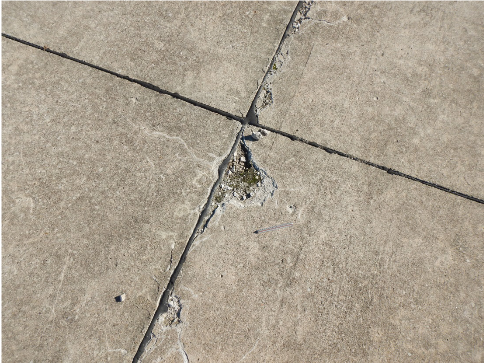
A01KE-01. ASR (Sample Unit No. 06).
