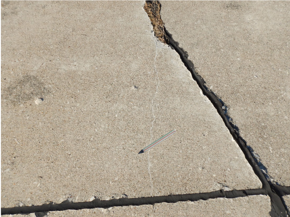
TBKE-02. ASR (Sample Unit No. 02).
