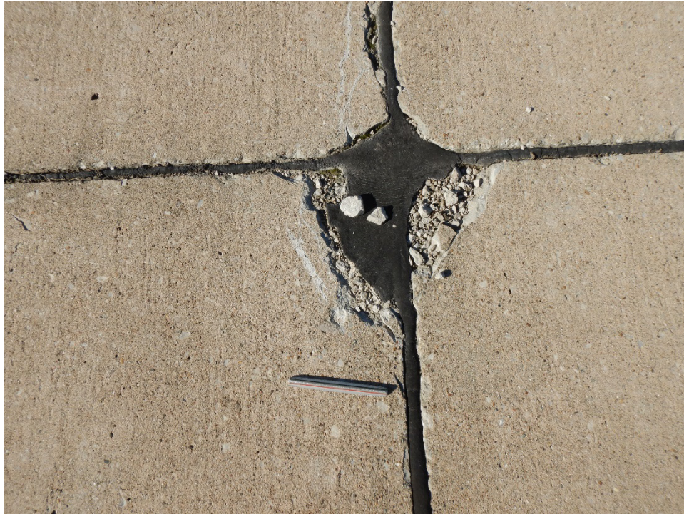
TBKE-01. ASR (Sample Unit No. 03).
