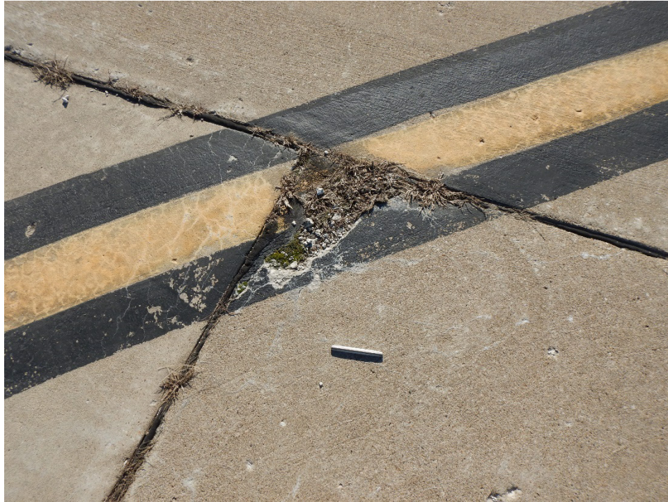
TBKE-03. ASR (Sample Unit No. 03).
