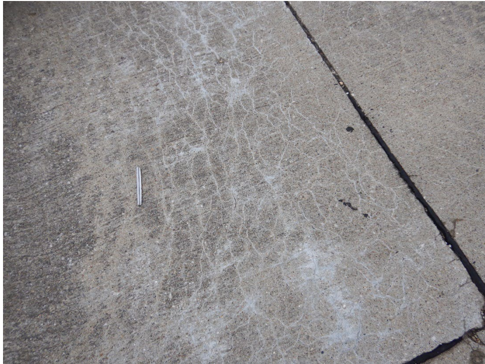
TH01KN-01. ASR (Sample Unit No. 04) (2).
