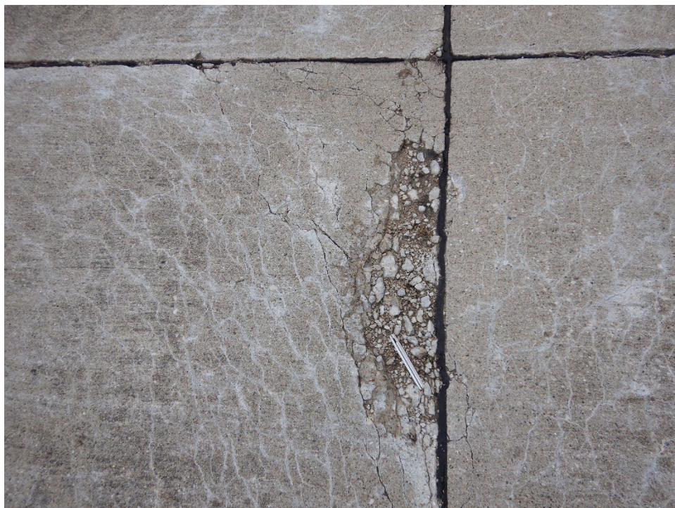
TH01KN-01. ASR (Sample Unit No. 04) (1).
