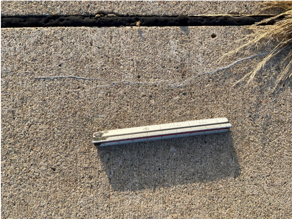
A01MQ-02. ASR (Sample Unit No. 02).
