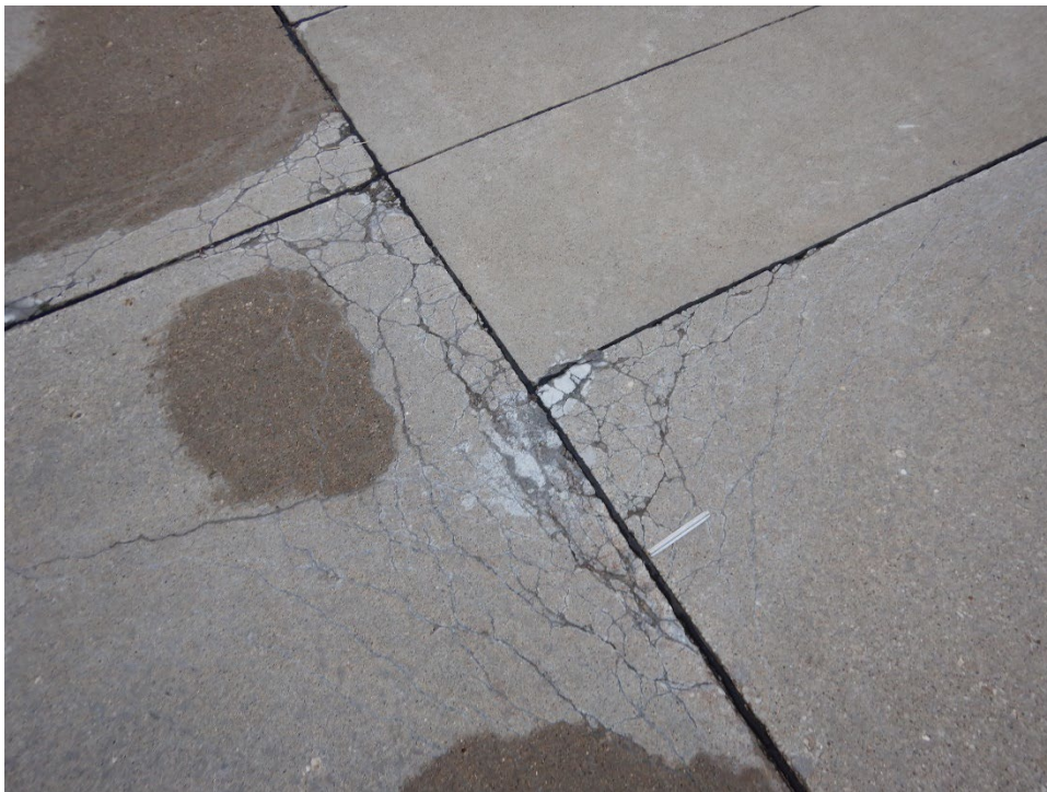
A01PE-01. ASR (Sample Unit No. 15).
