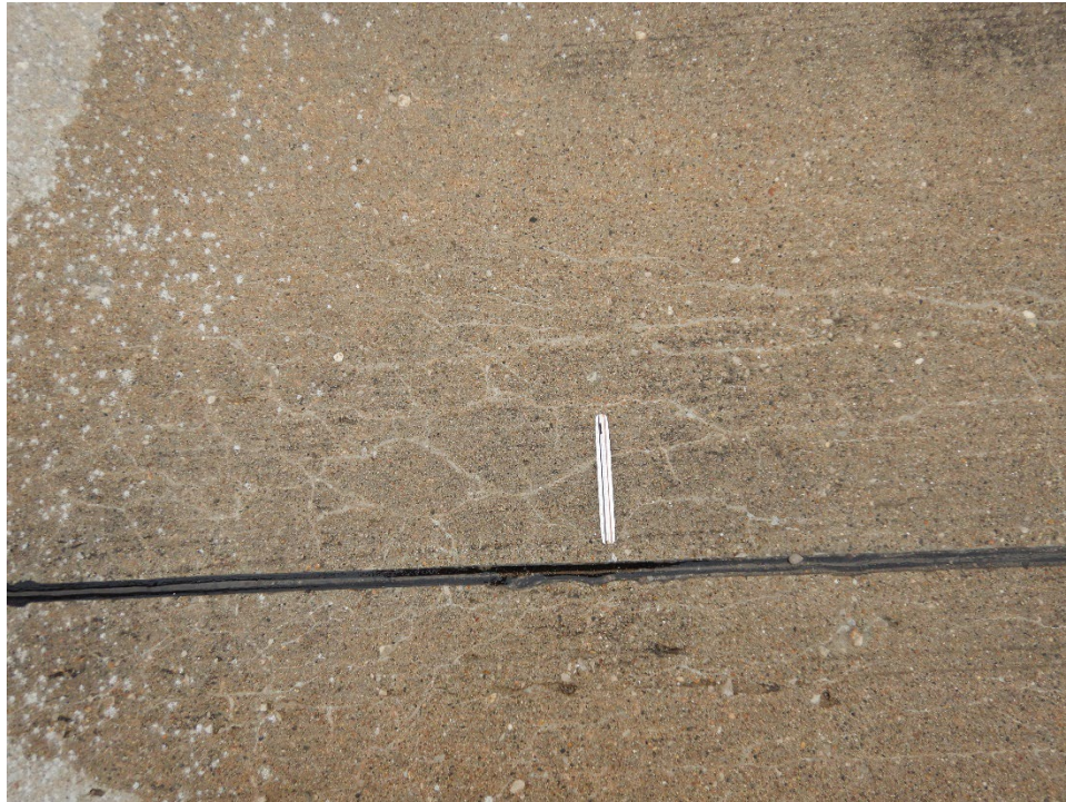
R16PE-05. ASR (Sample Unit No. 01).
