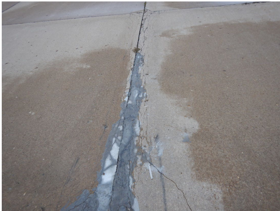
A01PE-02. ASR (Sample Unit No. 03) (2).
