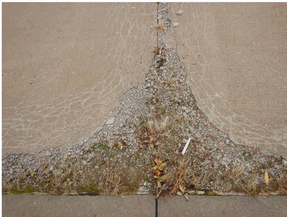
R16PE-11. ASR (Sample Unit No. 02) (1).
