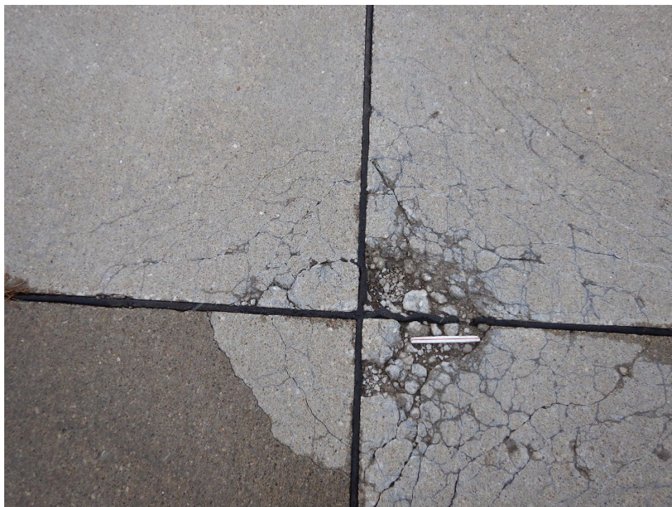
T01PE-01. ASR (Sample Unit No. 02).
