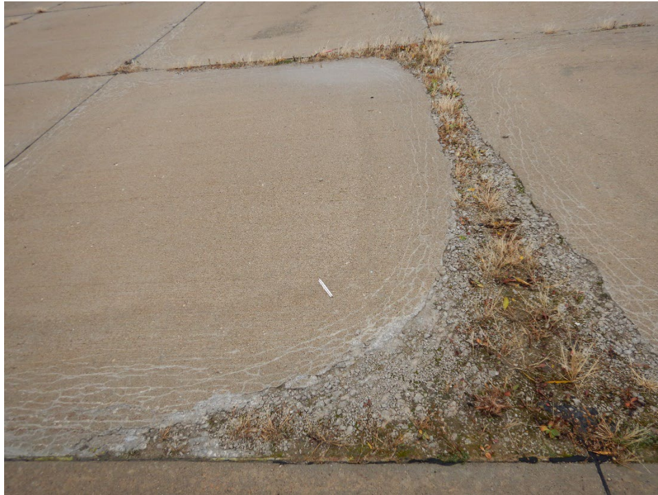
R16PE-11. ASR (Sample Unit No. 02) (2).
