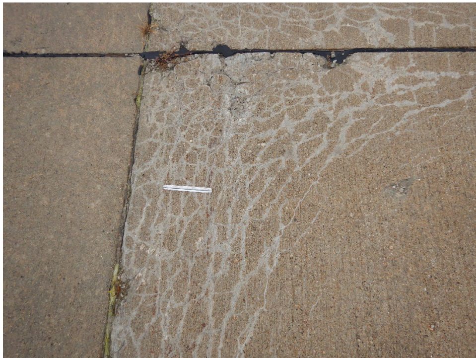
R16PE-11. ASR (Sample Unit No. 02) (3).
