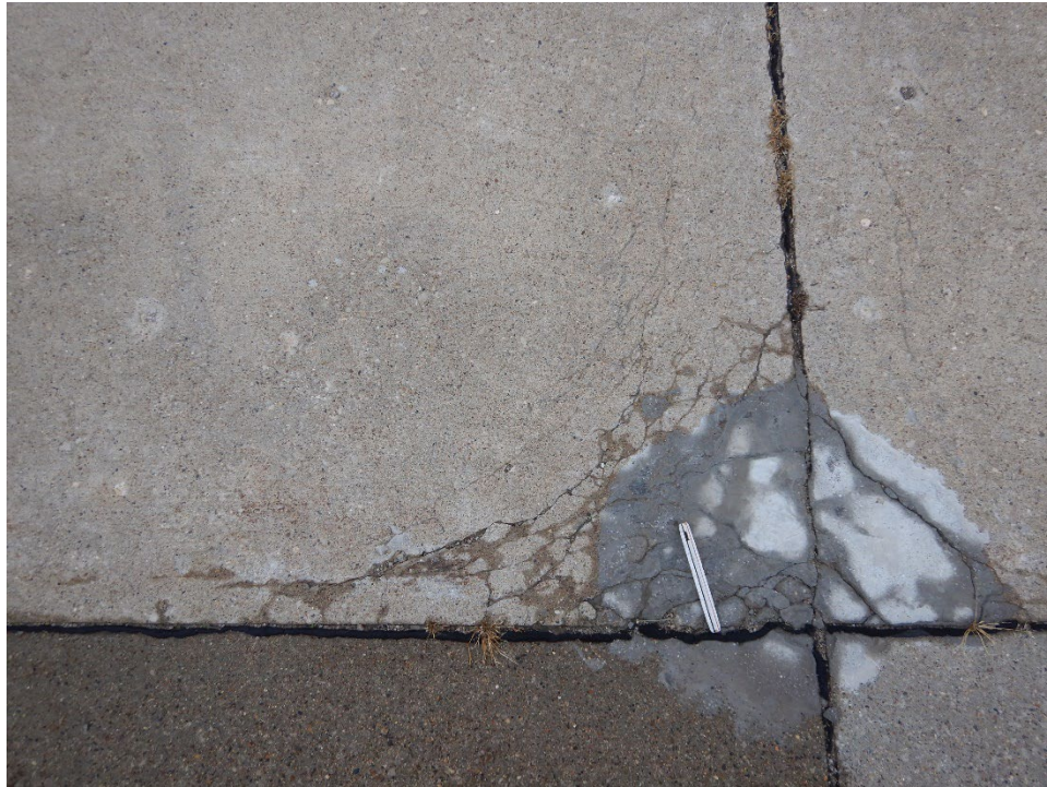
A01PE-02. ASR (Sample Unit No. 03) (1).
