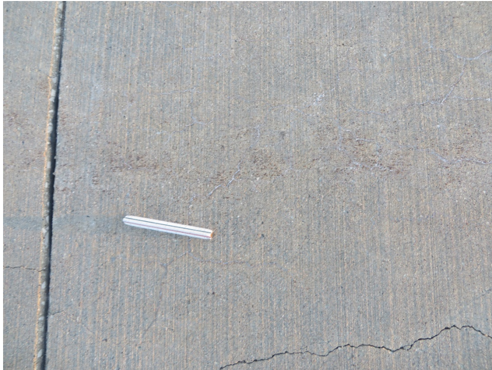
A01RC-02. ASR (Sample Unit No. 04).
