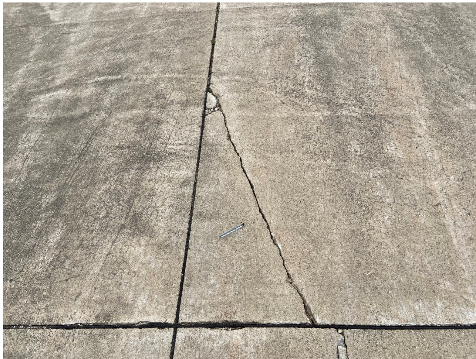
A01WU-03. Corner Break (Sample Unit No. 01).
