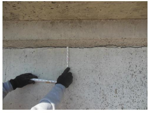
Figure 2.9.3.2-4. Cracking Along Web-to-Top Flange Interface
