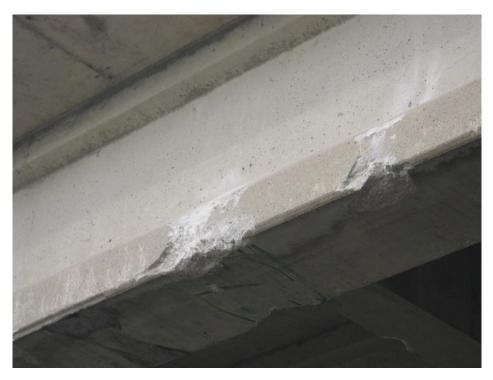
Figure 2.9.3.2-2. Minor Bottom Flange Spalling
